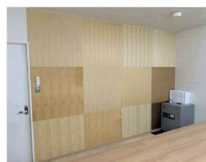
「天然木」壁紙の施工事例
